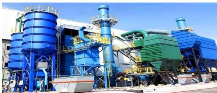
**Figura 11.** Exemplo de uma Central de Filtros de Mangas
